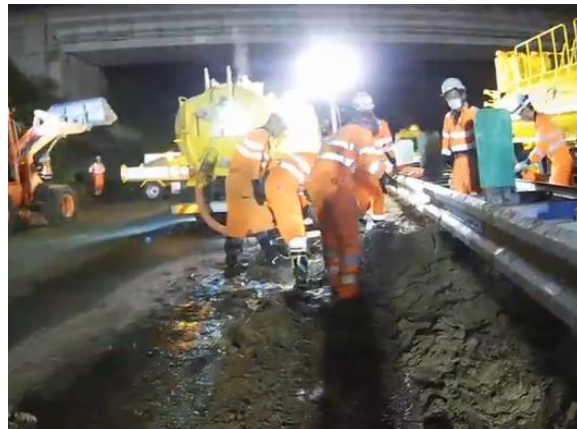
復旧作業状況
