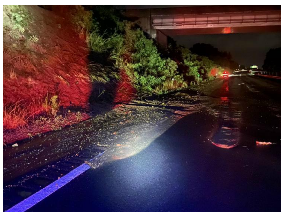
のり面の土砂流出状況
