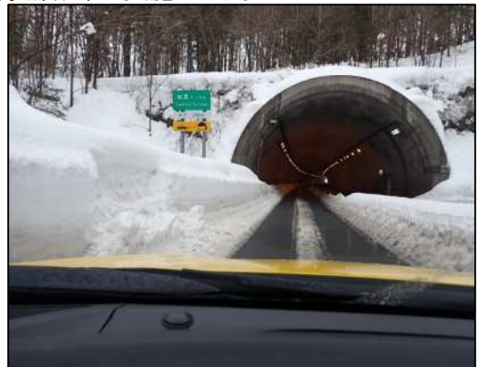
トンネル坑口付近堆雪状況
