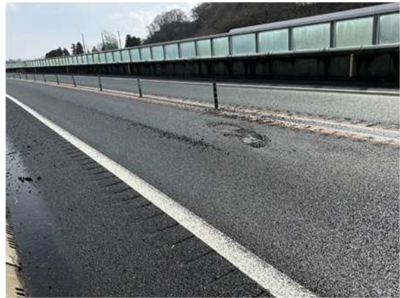
舗装損傷写真②
