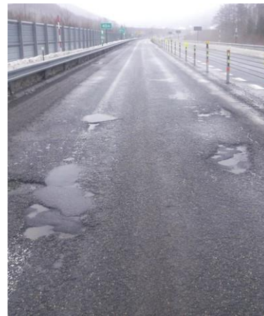
路面損傷状況
