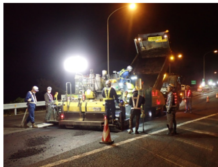
舗装補修工事作業状況
