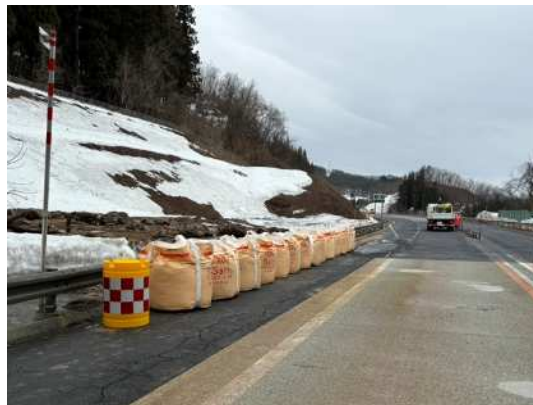
大型土のう 設置状況
