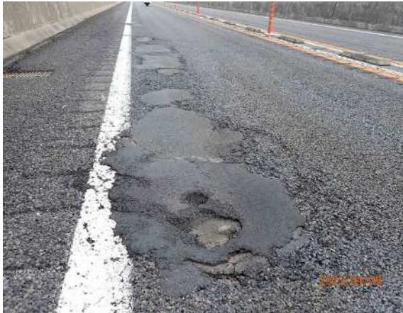
舗装損傷写真①
