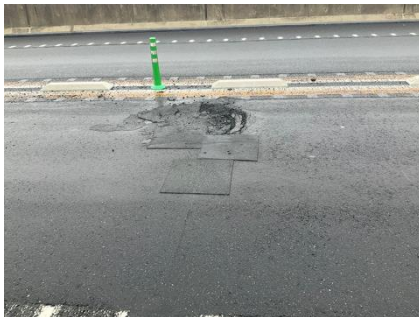
舗装損傷状況
