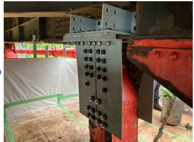
②箇所:応急対策後
