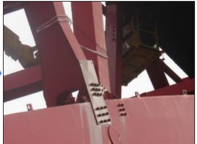
①箇所:応急対策後
