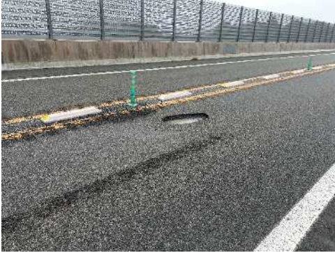
舗装の損傷
