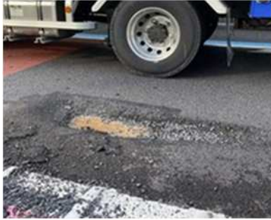
舗装損傷状況
