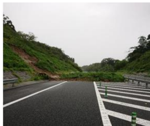
のり面の崩落
