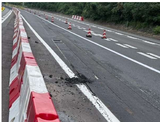
路面損傷写真
