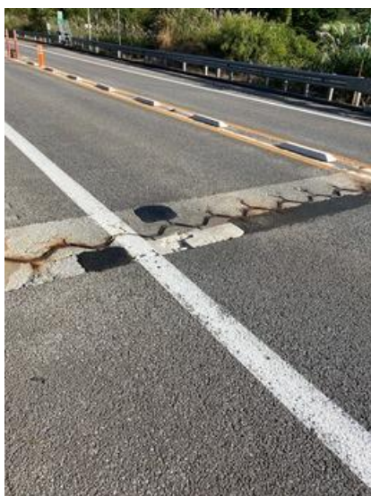
伸縮装置損傷状況
