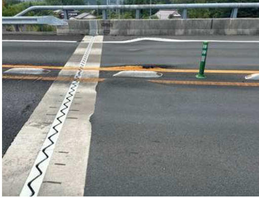
舗装の損傷
