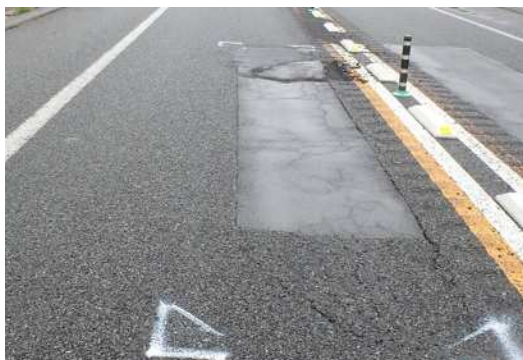
舗装の損傷
