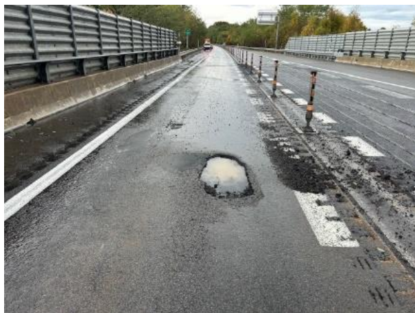
舗装の損傷状況
