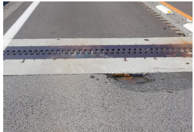
舗装の損傷状況
