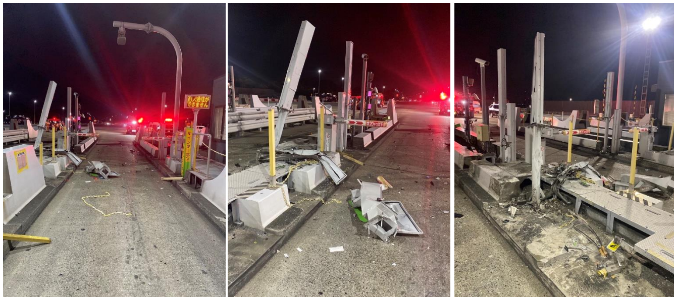
参考 交通事故により損傷したETCレーンの状況
