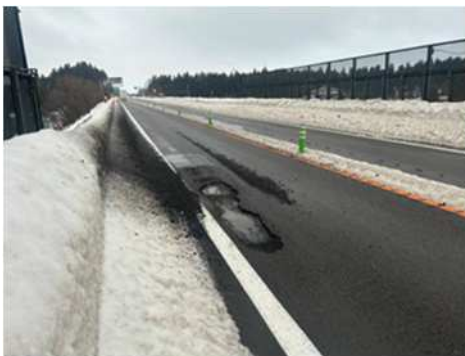
路面損傷状況
