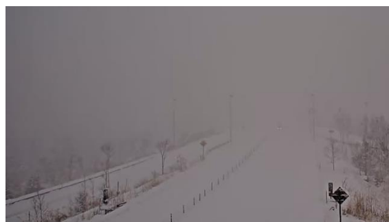
道央自動車道 長万部IC付近
