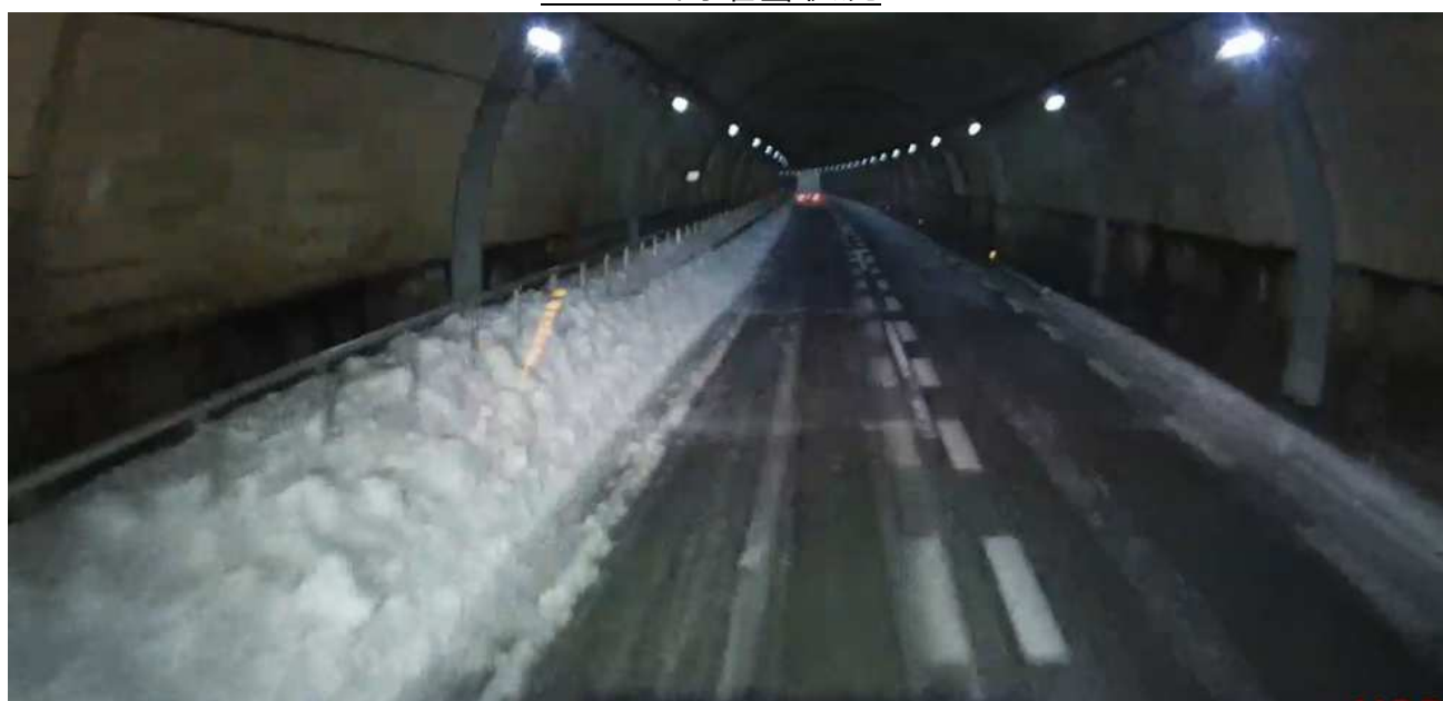
トンネル内堆雪状況
