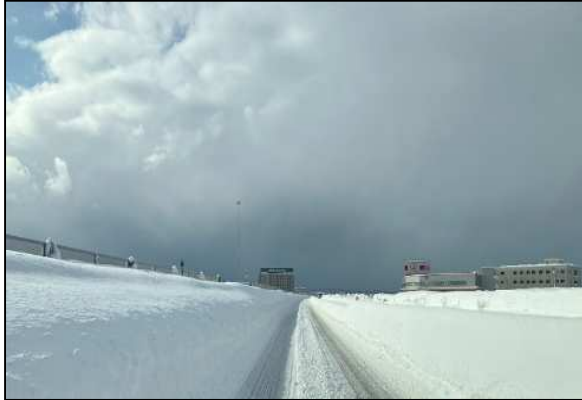
路肩堆雪状況
