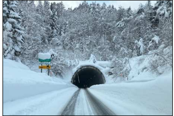
トンネル坑口付近堆雪状況
