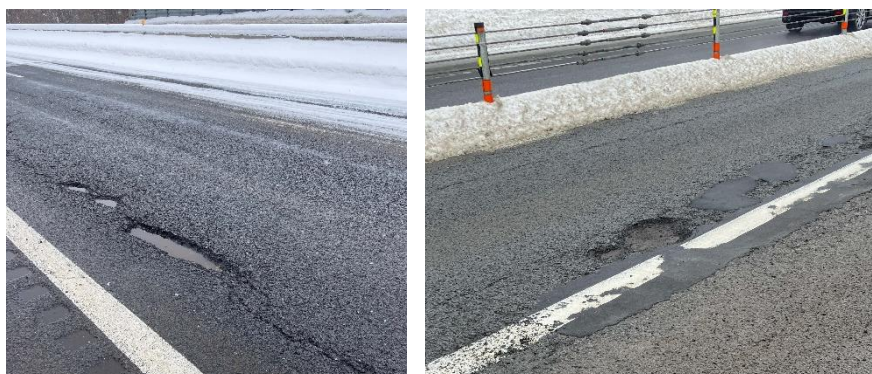
路面の損傷状況
