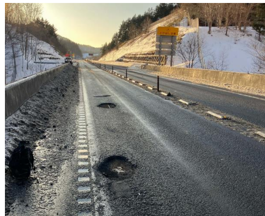
舗装の損傷状況
