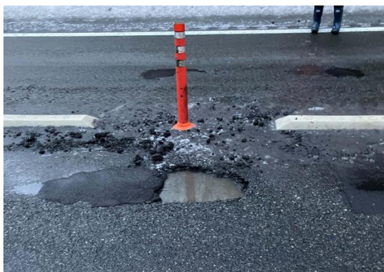
舗装の損傷状況
