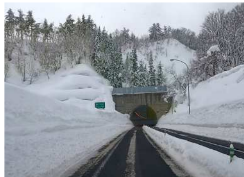
切土のり面の堆雪状況
