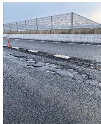
路面の損傷状況
