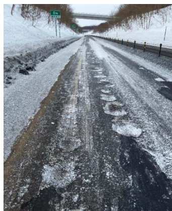
路面の損傷状況
