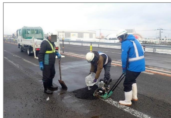
舗装補修工事の状況
