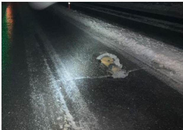
舗装の損傷状況
