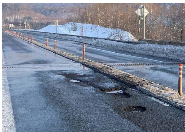
舗装の損傷状況
