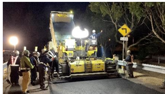
舗装補修工事 作業状況
