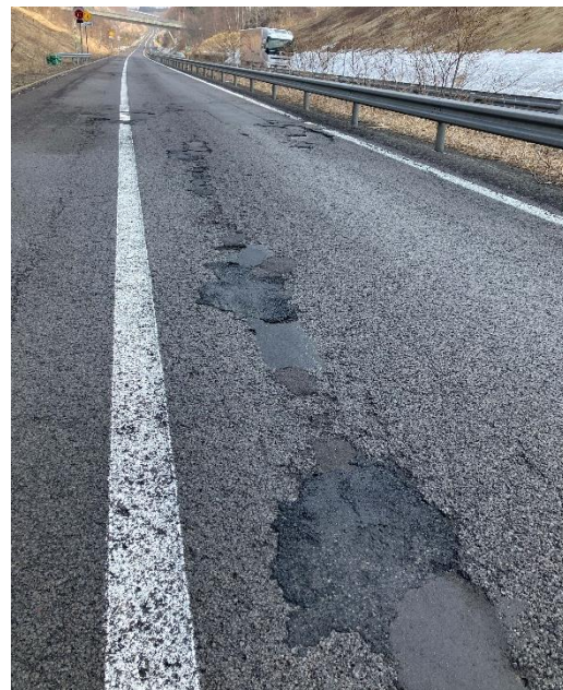
路面の損傷状況
