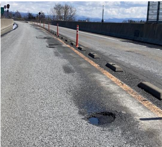
路面の損傷状況
