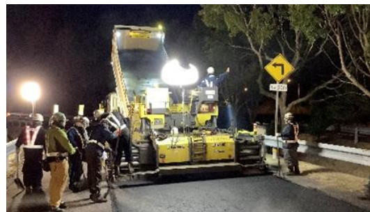
舗装補修工事 作業状況
