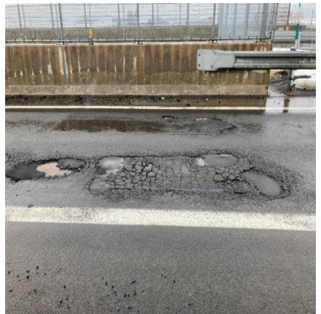
路面の損傷状況
