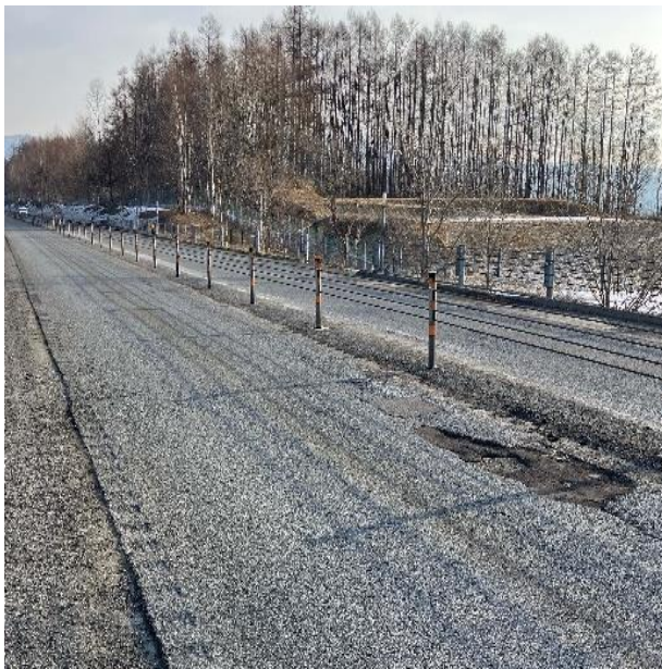
路面の損傷状況
