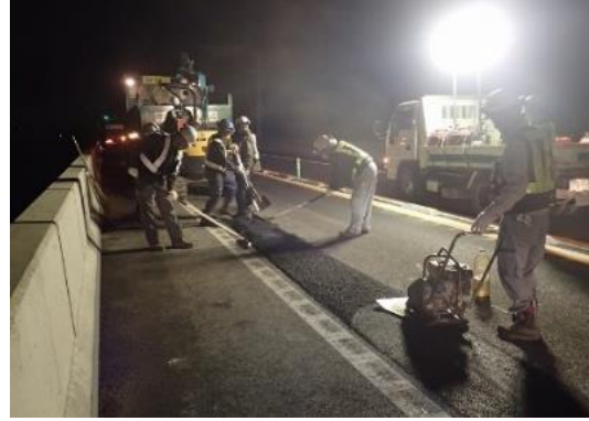
舗装補修工事 作業状況
