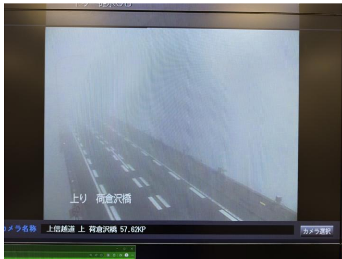
霧通行止め実施区間 E18 上信越道の様子
