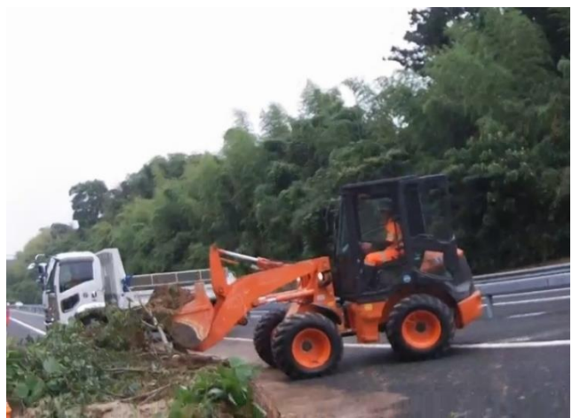
復旧作業状況
