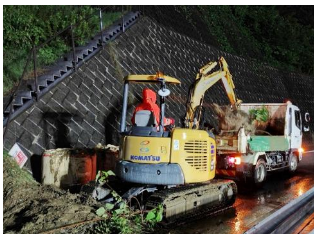
復旧作業状況(太田強戸スマートIC)
