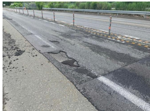
路面の損傷状況
