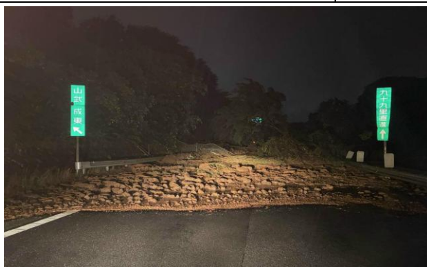
千葉東金道路の被災状況
