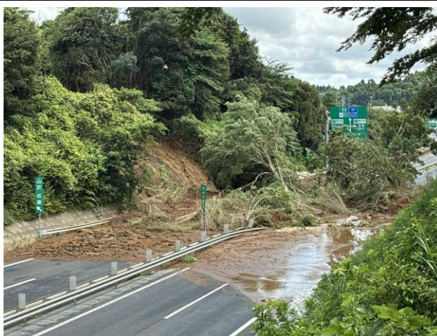
E82 千葉東金道路 （東金 JCT～山田 IC）の被災状況
