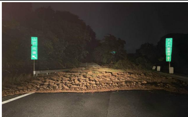
千葉東金道路の被災状況
