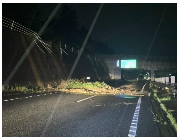
首都圏中央連絡自動車道の被災状況
