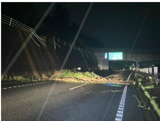
首都圏中央連絡自動車道 （茂原長南 IC～茂原北 IC）の被災状況
