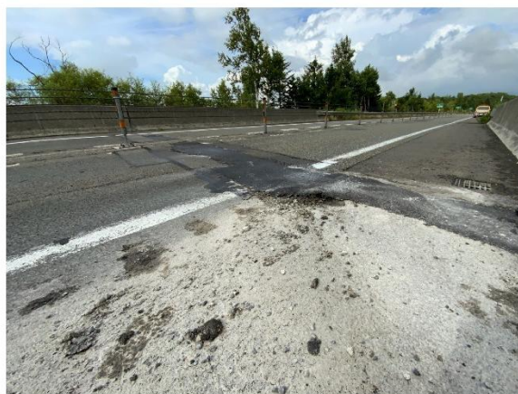
路面の損傷状況
