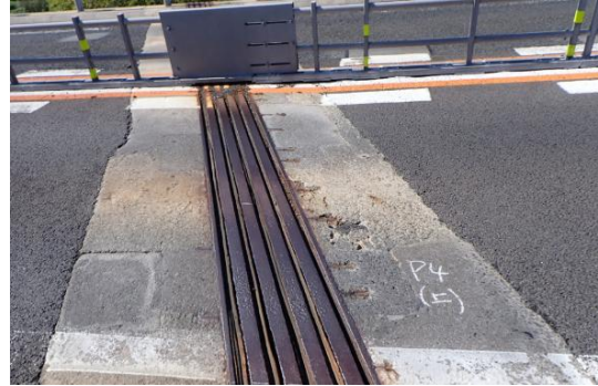
伸縮装置 補修後イメージ
