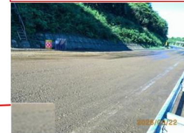
千葉東金道路 上り線 14.5KP
