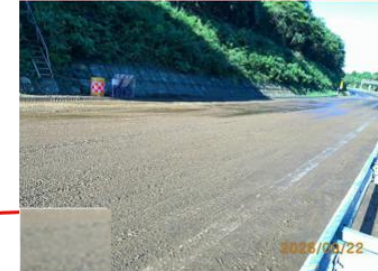
千葉東金道路 上り線 14.5KP
