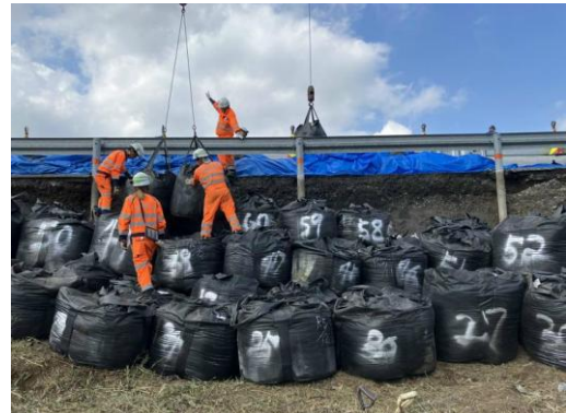
作業状況写真
