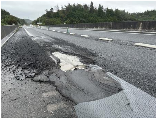
舗装損傷写真
