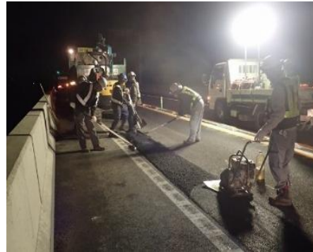
舗装補修工事 作業状況
